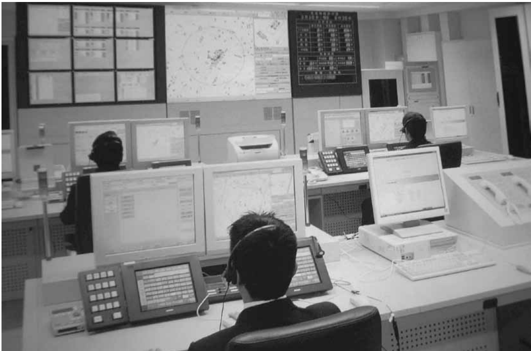
●消防本部通信指令室
